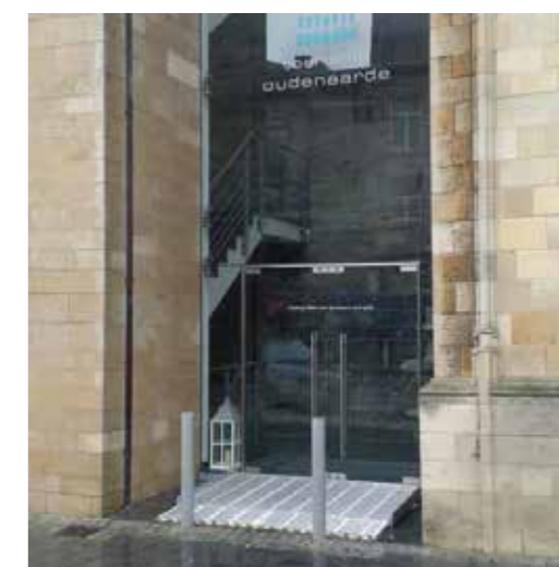
Plateforme d'accès bâtiment public Audenaarde
